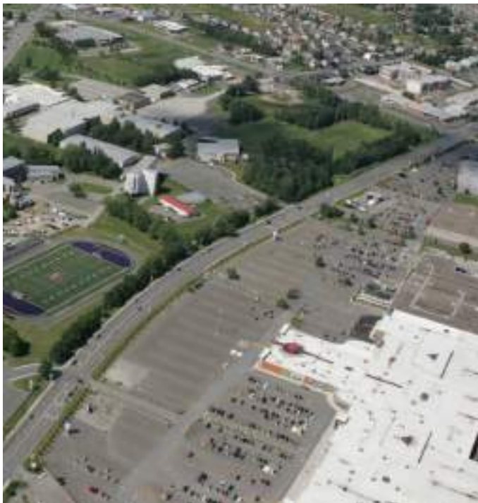
LE CENTRE DE VICTORIAVILLE SUR LE BOULEVARD JUTRAS EST
