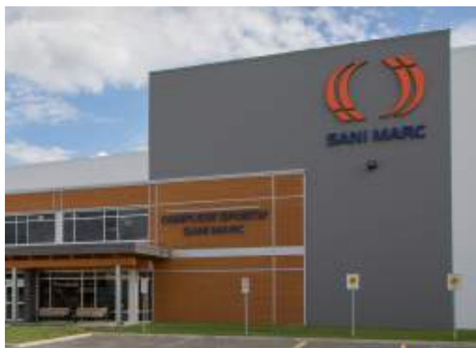
COMPLEXE SPORTIF SANI MARC
