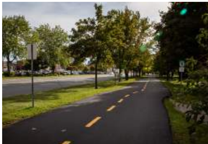
TRONÇON DE LA ROUTE VERTE À VICTORIAVILLE
