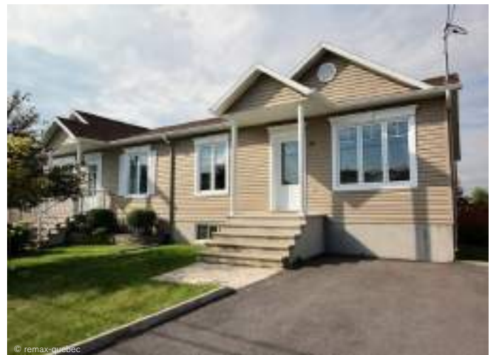
MAISONS JUMELÉES SUR LA RUE BIRON
