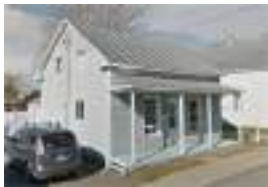
20, rue des Hospitalières
