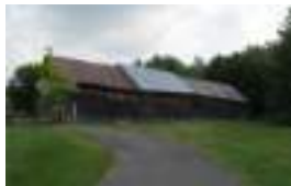
17, rue Laurier Est (Bâtiment secondaire)
