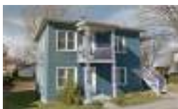
40-42, rue des Hospitalières
