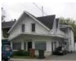
7-7B, rue Laurier Ouest
