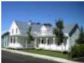
22-24, rue des Hospitalières
