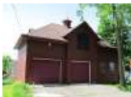
19, rue Laurier Ouest (Bâtiment secondaire)
