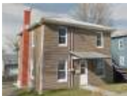
36-38, rue des Hospitalières
