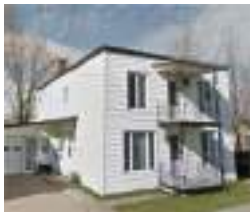
32-34, rue des Hospitalières
