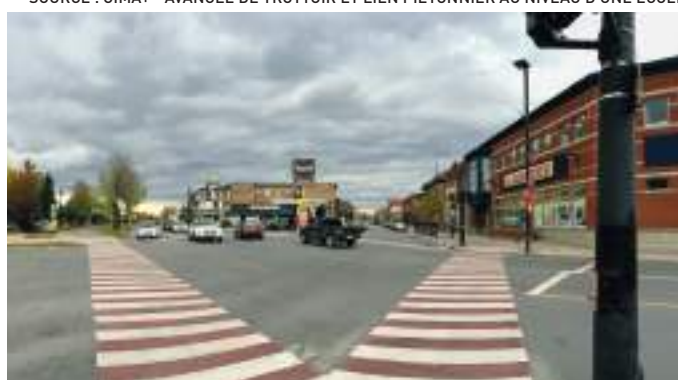
SOURCE : FLICKR, VILLE DE VICTORIAVILLE - TRAVERSE PEINTE ROUGE ET BLANCHE (NON CONFORME SELON LES EXIGENCES DU MTMD 2 )
