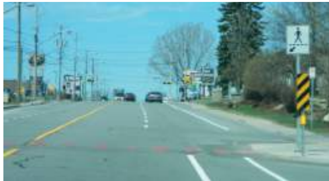
SOURCE : CIMA+ - TRAVERSE PIÉTONNE PEINTE EN ROUGE
