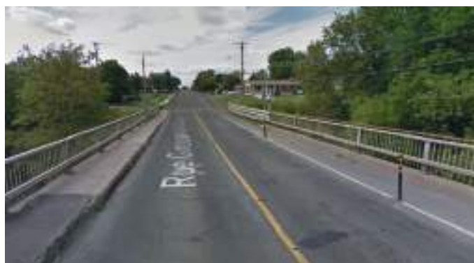
SOURCE : GOOGLE MAPS - PONT DE LA RUE GIROUARD
