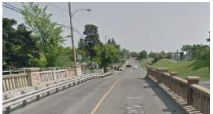
SOURCE : GOOGLE MAPS - PONT DE LA RUE GAMACHE
