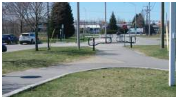
SOURCE : CIMA+ - PRÉSENCE DE BARRIÈRES POUR LIMITER L'ACCÈS À LA PISTE
