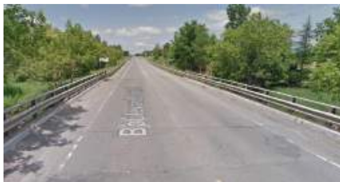
SOURCE : GOOGLE MAPS - PONT DU BOULEVARD JUTRAS
