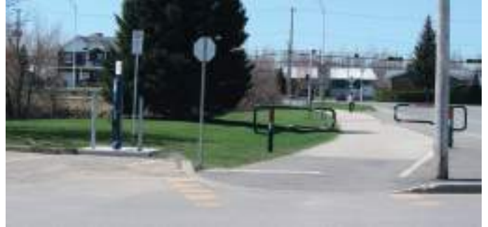
SOURCE : CIMA+ - BORNE ÉLECTRIQUE DU RÉSERVOIR BEAUDET
