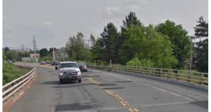
SOURCE : GOOGLE MAPS - PONT DE LA GRANDE-LIGNE
