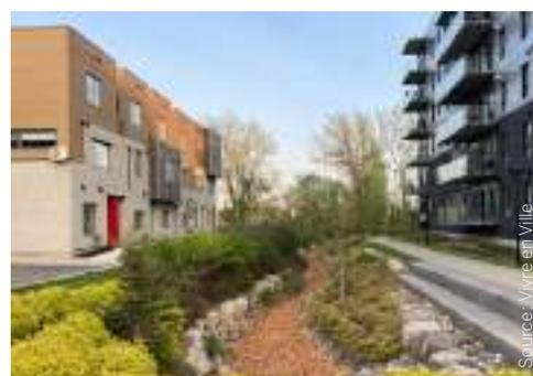
Fossés de rétention mis en réseau vers un bassin filtrant au sein d'un projet d'ensemble.
