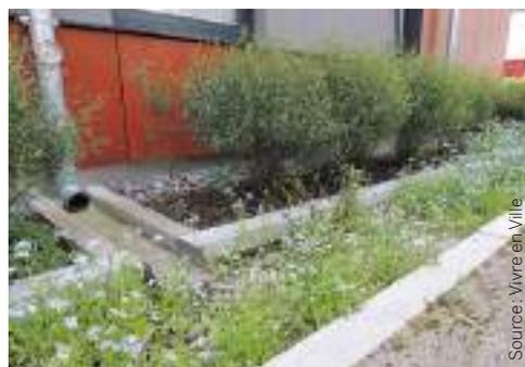
Tranchée filtrante absorbant l'eau des gouttières.
