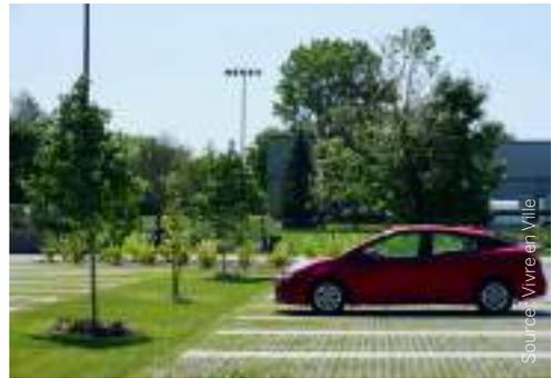
Surface en pavé alvéolé | Tranchée filtrante intégrant des arbres à grand déploiement.
