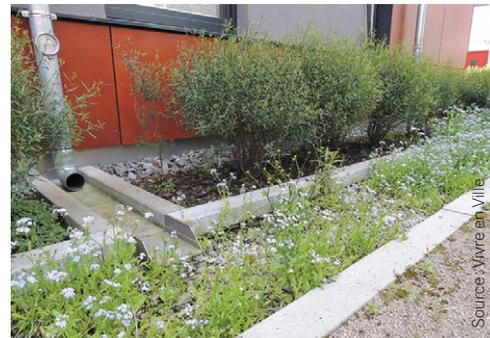
Tranchée filtrante absorbant l'eau des gouttières.
