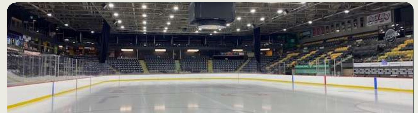
Conversion de l'éclairage, remplacement des bandes et amélioration de la réfrigération au Colisée Desjardins
