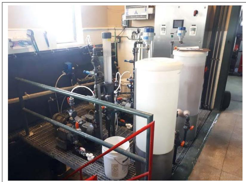
Photo 6 : Vue des doseuses de silicates et aluminates (8 octobre 2019)
