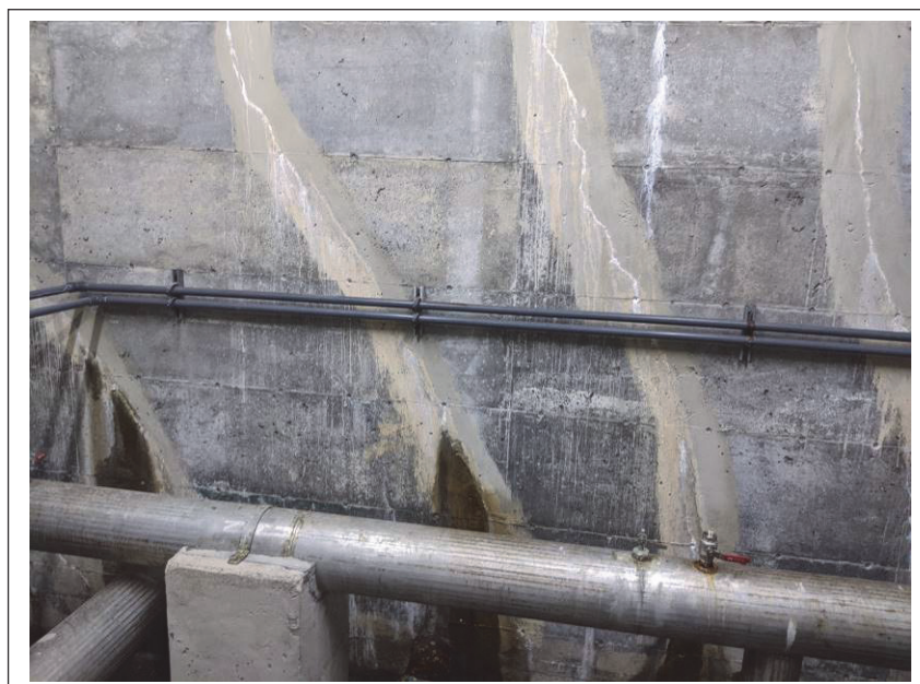
Photo 10 : Vue du mur retenant le bassin sous l'usine (17 septembre 2020)
