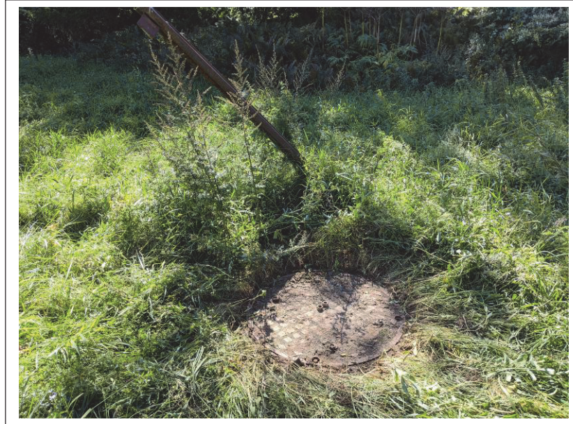
Photo 5 : Vue du puits P-1 Arthabaska (17 septembre 2020)
