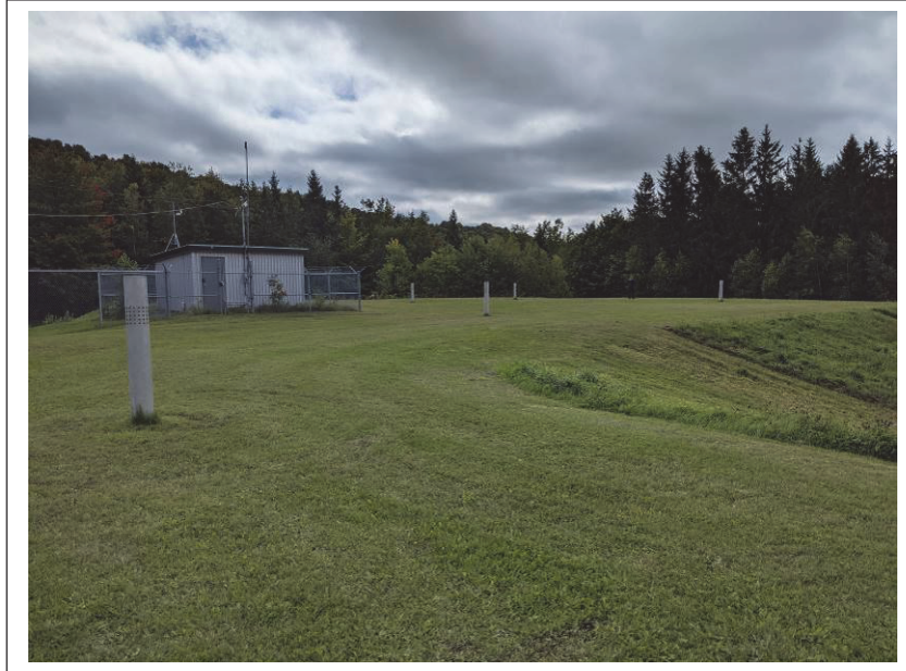
Photo 21 : Vue du réservoir Saint-Michel (17 septembre 2020)
