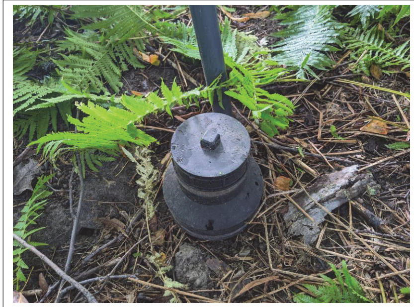
Photo 13 : Vue du piézomètre 1 pour le puits Victoriaville (17 septembre 2020)
