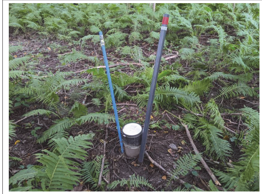
Photo 15 : Vue du piézomètre 3 pour le puits Victoriaville (17 septembre 2020)
