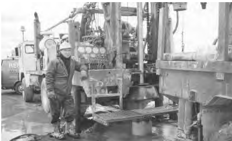
Fabien Massé, auprès d'une foreuse.
