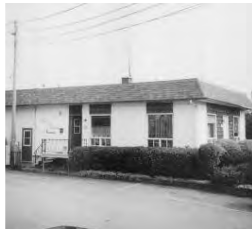
Ancien bureau administratif.
