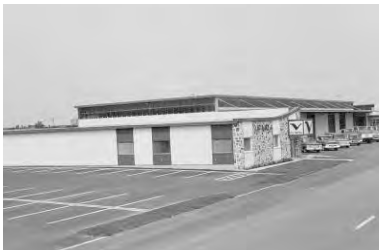
L'usine de galvanisation sur la rue De Bigarré où nous retrouvons aujourd'hui le service de voirie de la Ville de Victoriaville.
