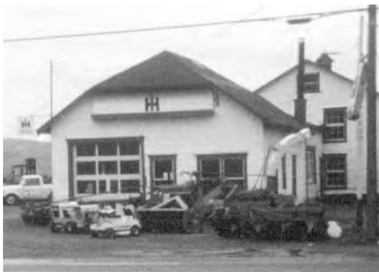
Les premières installations du 951 rue Notre-Dame Est.
