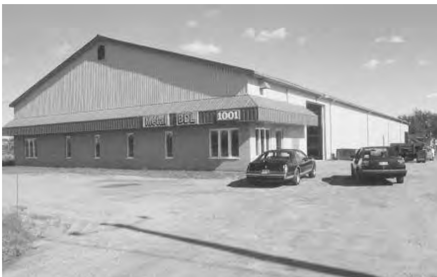
L'usine au 1001 boulevard Industriel.
