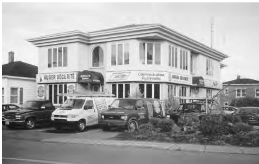
Les bureaux du 374 rue Notre-Dame Est où l'entreprise déménage en 1991.
