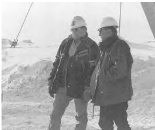
Le président Aubert sur un chantier.
