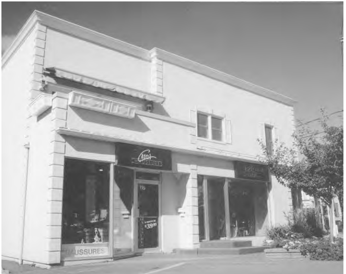
Rénové en 1989, l'édifice du 115 boulevard des Bois-Francis Sud n'a cessé depuis de s'attirer les éloges de tout un chacun.
