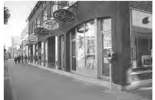
La façade du commerce sur la rue Notre-Dame Est après qu'elle fut refaite en 1998.
