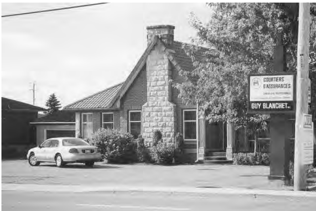
Depuis 1978, les locaux de Guy Blanchet inc. sont situés au 255 boulevard des Bois-Francis Sud.
