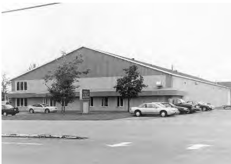
L'usine, en 1999, au 225 boulevard de la Bonaventure.
