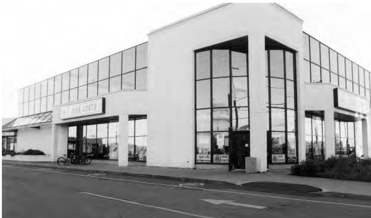
Vue extérieure du centre d'achats abritant la pharmacie.
