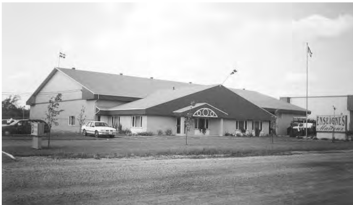
Le bâtiment actuel au 850 rue de L'Acadie.
