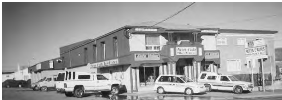
Les installations du 610 boulevard des Bois-Francis Sud.
