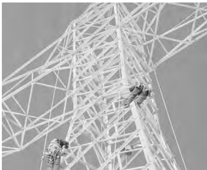
Monteurs de lignes, pas nécessairement un métier de tout repos.
