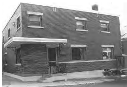
Après les réparations de 1962.
