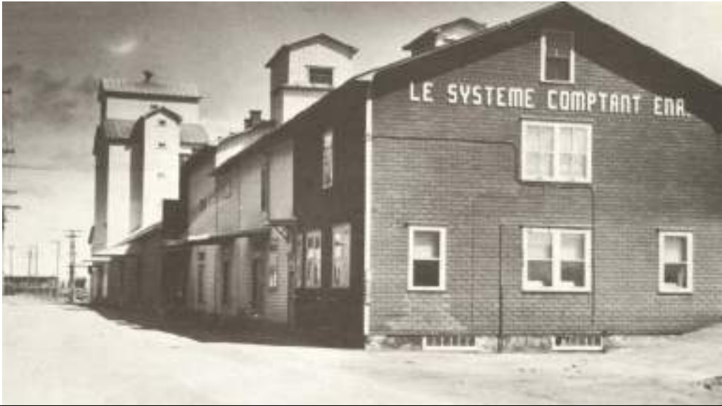
Photographie de l'ancienne bâtisse de « Le Système Comptant enr. » construite le long de la rue Saint-Louis dans l'emprise du chemin de fer du Grand Tronc à l'emplacement des anciens commerces « Flour & Grain C. O. Roberge » et « The Victoriaville Flour & Grain Co. (L. O. Pépin & Fils ) ».
