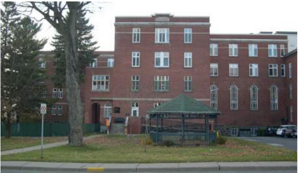
Site de la maison et boutique de forgeron d'Uldoric Béliveau 1854-1859 (aujourd'hui, le 44 rue Laurier Est)
