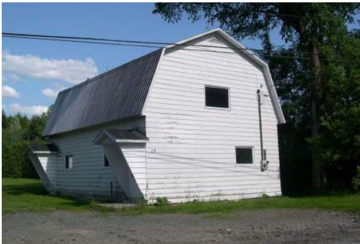
L'ancienne boutique de meubles devenue local des scouts (aujourd'hui, le 10 rue Pellerin)
