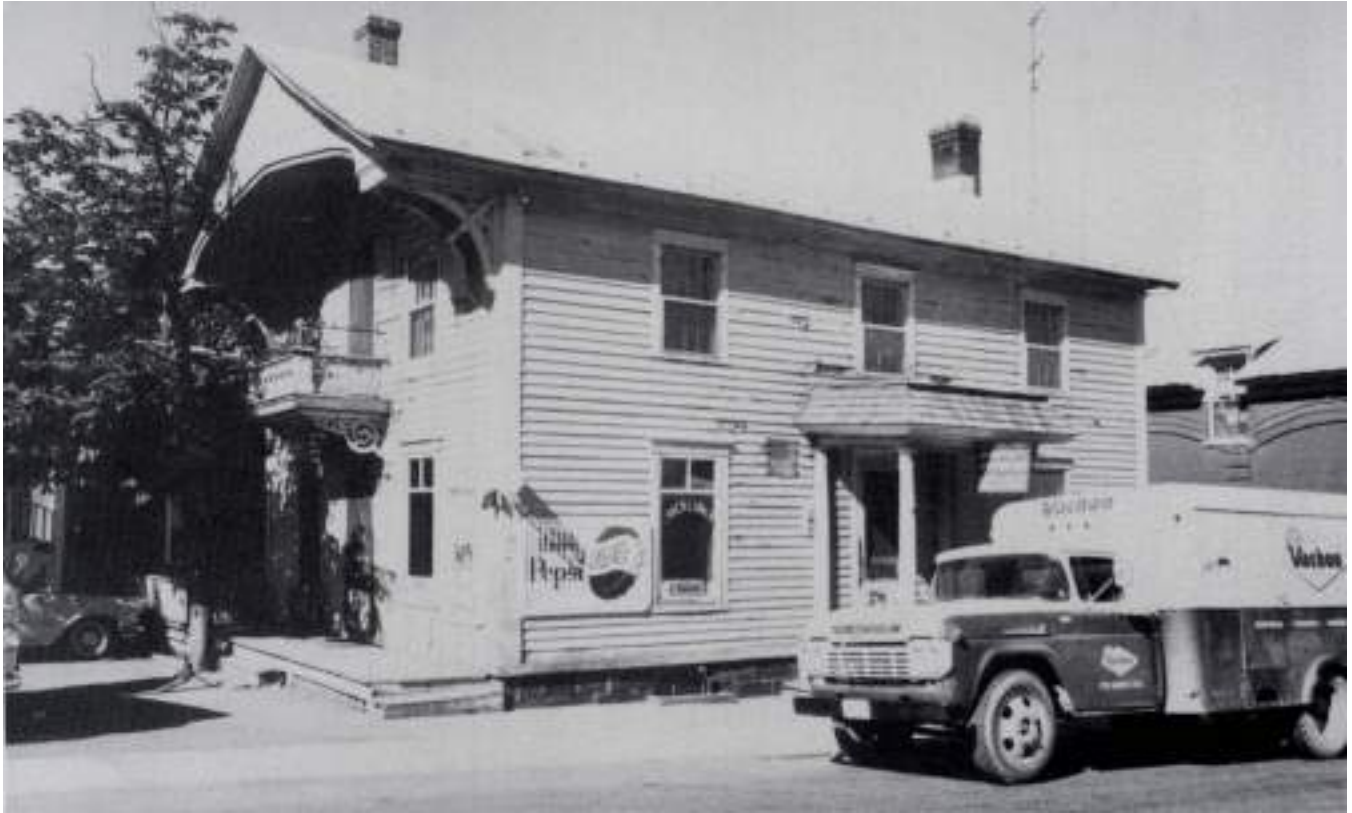
Maison de Louis-Ovide Pépin transformée en restaurant
