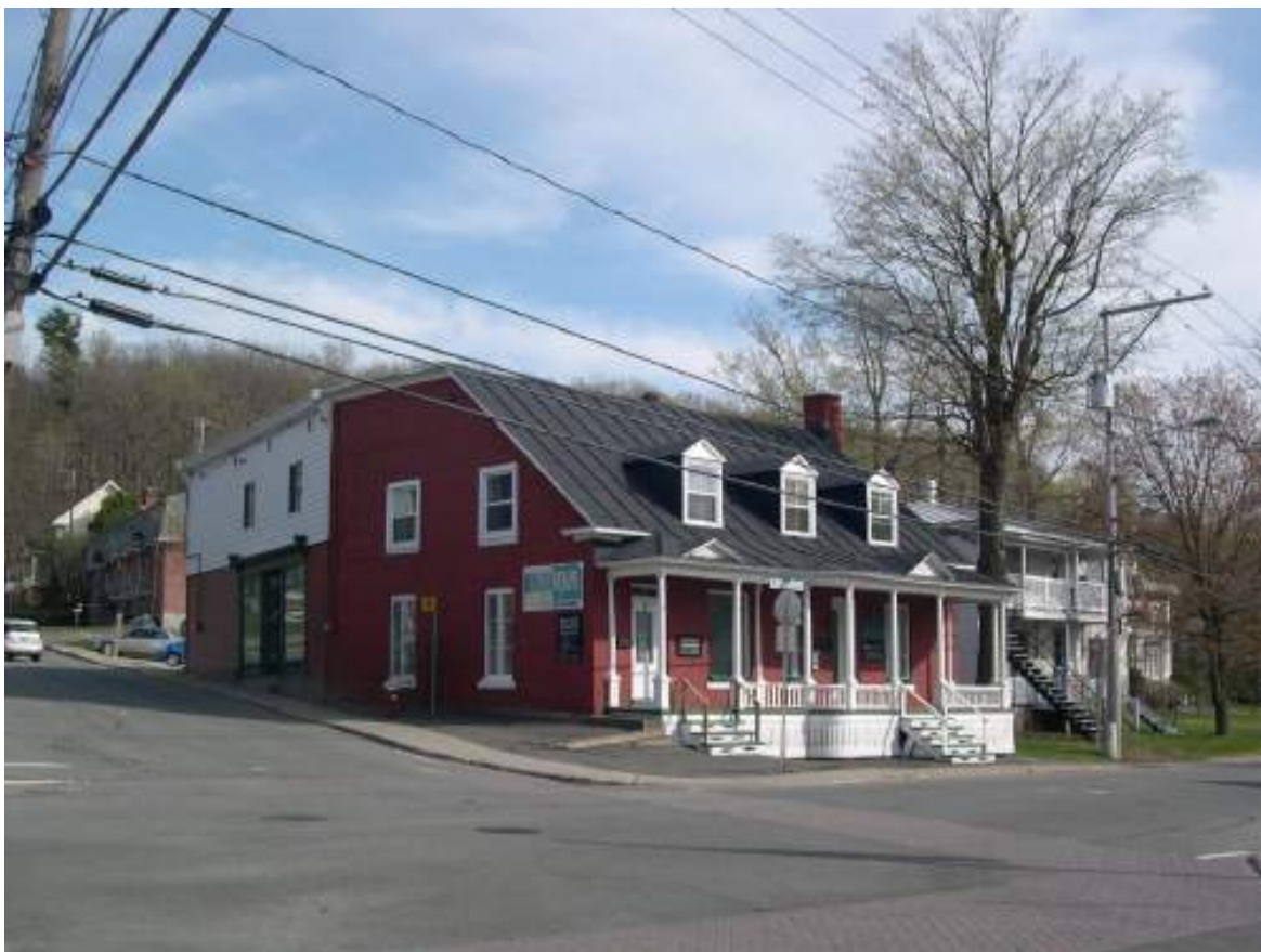
Site de la forge de Pierre Beauchesne, de 1849 à 1854 aujourd'hui, le 2-4 rue Laurier Ouest
