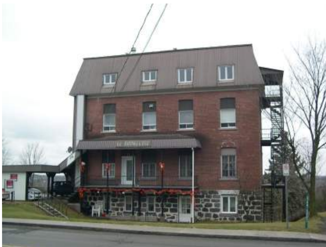
Ce qu'il reste du couvent d'Arthabaska en 2012 – L'aile nord construite en 1931 (aujourd'hui, le 73 rue Laurier Ouest)
