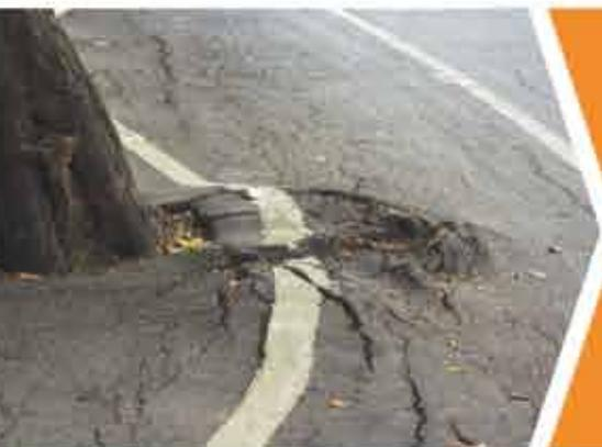
Les trottoirs et l'asphalte sont brisés ou soulevés par l'usure du temps, par l'action du climat ou par la machinerie lourde. Les racines sont incapables d'exercer une pression sur quoi que ce soit, **elles se moulent plutôt aux objets avec lesquels elles entrent en contact.**
